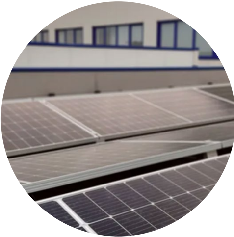
Installation av solceller på flera anläggningar
